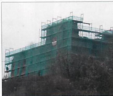
Nach wie vor im „grünen Gewand“. Die Sanierung der Ruine erfordert seine Zeit.
