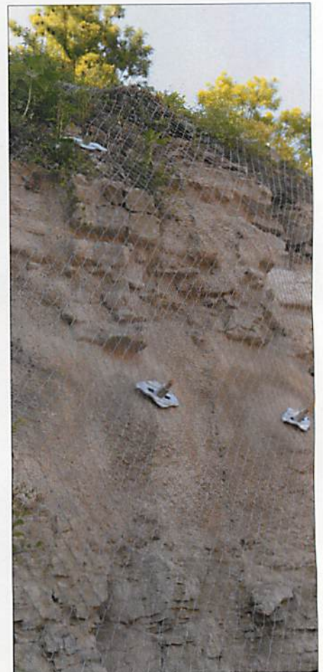
Die Sicherungsarbeiten sind so gut wie abgeschlossen.
